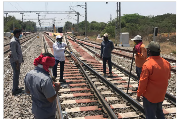
ట్రాక్ నిర్వహణ పనులు
