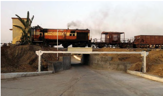
గుంటూరు సమీపంలో రోడ్ అండర్ బ్రిడ్జి
