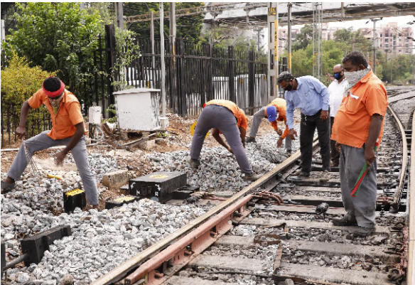
పురోగతిలో ఉన్న ట్రాక్ నిర్వహణ పనులు
